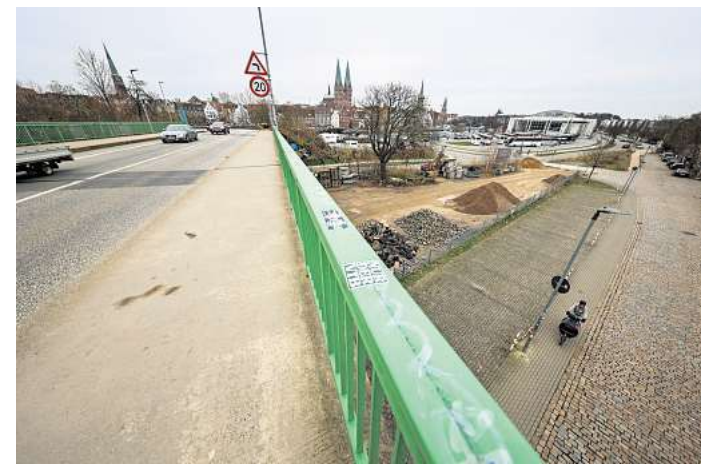
An der Marienbrücke sind von jetzt an bis voraussichtlich zum 2. September Reparaturarbeiten geplant. Archivfoto: Lutz Roessler
