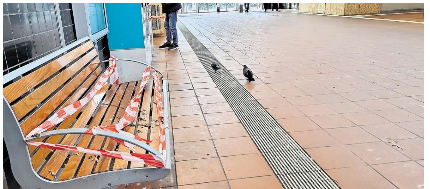
Am Hauptbahnhof Lübeck mussten schon Sitzbänke wegen der Hinterlassenschaften von Tauben gesperrt werden.
