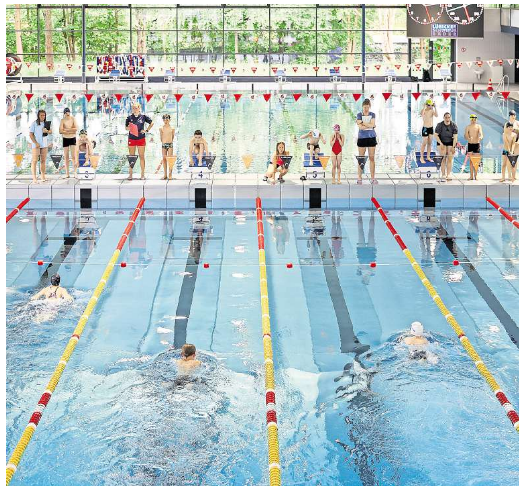
Die Lübecker Schwimmbäder – hier das Sportbad St. Lorenz – benötigen viel Wärme. Erneuerbare Energien sollen die Kosten drücken. Fotos: Lutz Roebler
