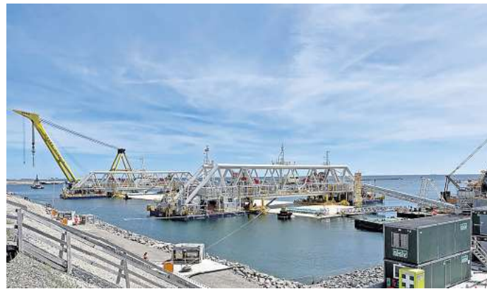
Das zweite Tunnelement, das vor Dänemark abgesenkt werden soll, wird von den Spezialschiffen „Ivy1“ und „Ivy2“ gehalten. Sobald die Wetterbedingungen stimmen, kann es losgehen. Foto: Manuel Büchner
