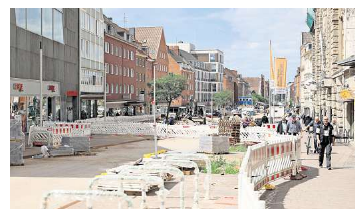
Der obere Teil der Beckergrube wird aktuell aufgehübscht. Im November sollen die Arbeiten beendet sein.
