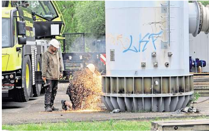
Am Schaft werden die Haltebolzen abgebrannt, um den Schornstein auszuheben. Fotos: Holger Kröger
