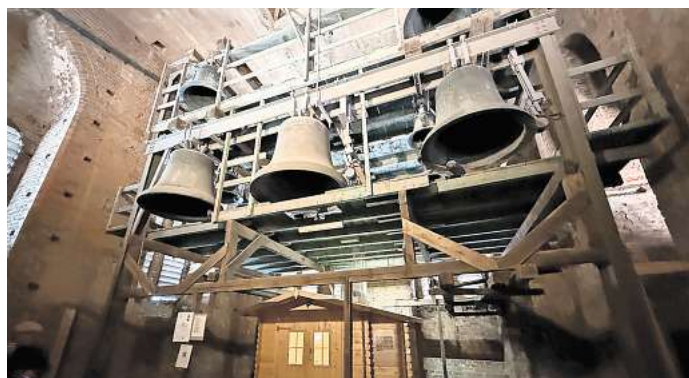
Das kleine Geläut im Südturm: In dem Häuschen befindet sich ein kleiner Computer, mit dem die Glocken seit 2008 programmiert werden. Vorher wurden sie mit Walzentechnik betrieben.
