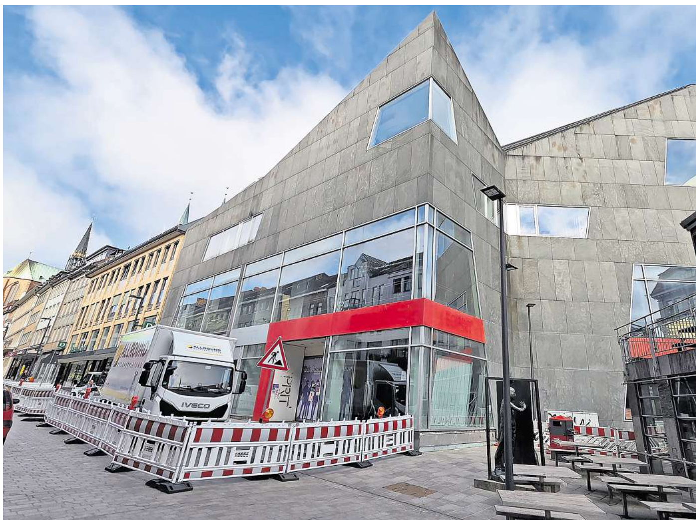
Sieben Jahre stand das markante Geschäftsgebäude in der Breiten Straße leer. Jetzt wird innen erst einmal umgebaut, bevor Ende des Jahres neue Mieter einziehen sollen. Foto: Holger Kröger
