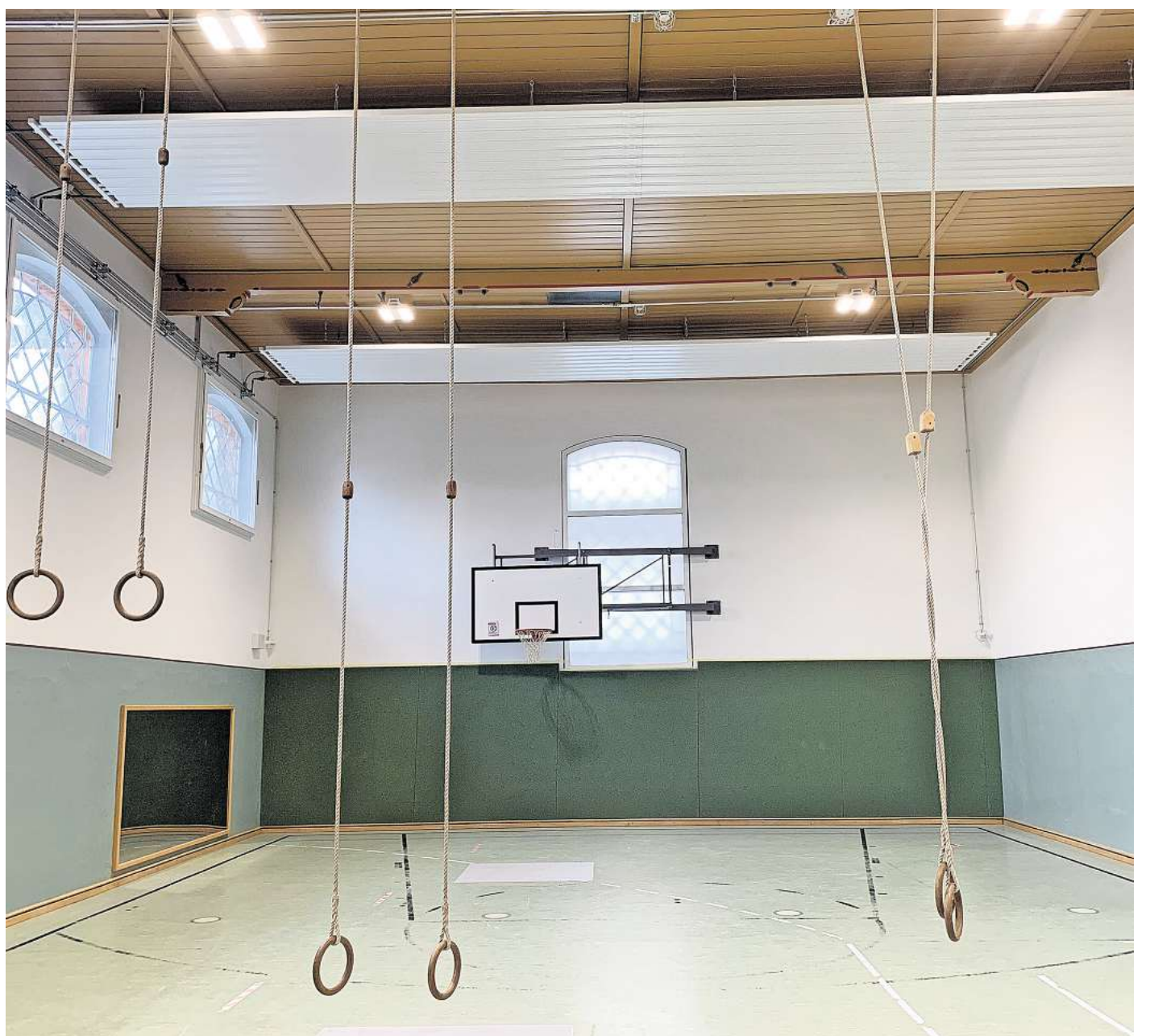
Hier kann wieder Sport gemacht werden: Die sanierte Turnhalle der Kaland-Schule erstrahlt in neuem Glanz.
