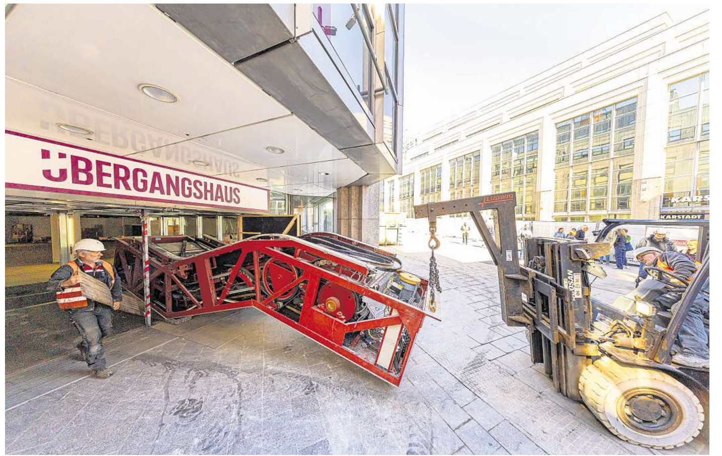
Da ist Präzisionsarbeit gefragt: Die erste Rolltreppe verlässt das frühere Karstadt-Gebäude B durch den Haupteingang. Fotos: Agentur 54°
