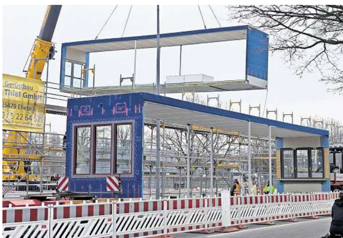
36 Module, die jeweils 16,5 Meter lang sind, werden in der Kanalstraße abgeladen und zu einer Schule montiert. Foto: Holger Kröger
