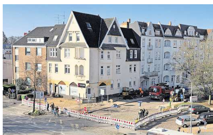
Baufahrzeuge und das Ordnungsamt der Hansestadt Lübeck im Einsatz in St. Lorenz Nord: Dort wurde eine Terrasse abgetragen.
