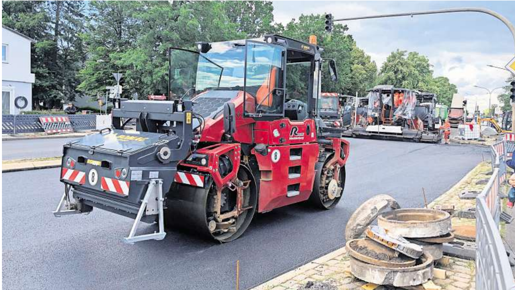
Von Mai bis September sollen in Lübeck voraussichtlich 37 Straßen per DSK-Verfahren saniert werden. Der Asphalt für DSK besteht aus einem Gemisch aus groben und feinen Gesteinskörnungen, Bitumenemulsion, Zusätzen und Wasser.
