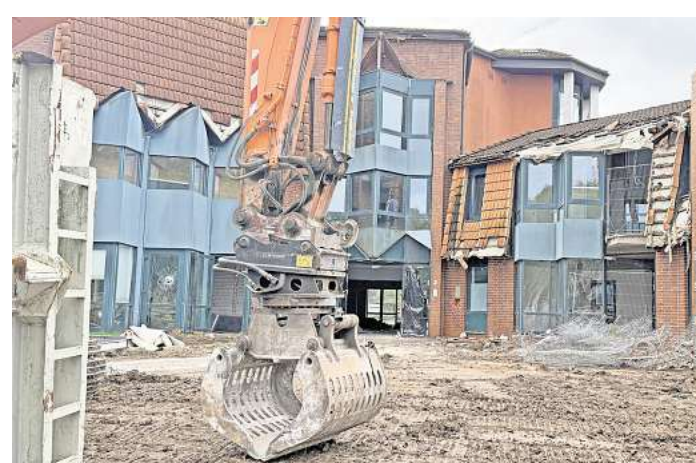
Der Abriss des ehemaligen Pommernzentrums an der Travemünder Ostseestraße begann vor einem halben Jahr. Foto: Thomas Krohn
