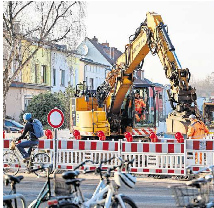
Auch in der Margarethenstraße wird in diesem Jahr weitergebaut.
