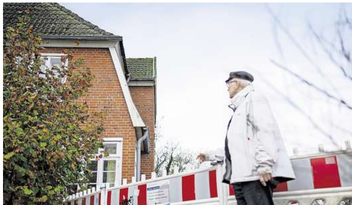
Bauingenieur Dr. Georg Heerten sieht noch eine Chance, das Haus Seeblick zu retten. Foto: Agentur 54°
