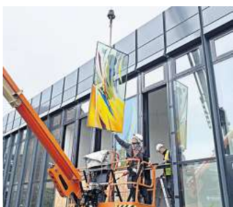
Schritt für Schritt entsteht die neue Fassade: Monteure setzen die Fenster des Raums der Stille im UKSH Lübeck ein. Foto: KKLL
