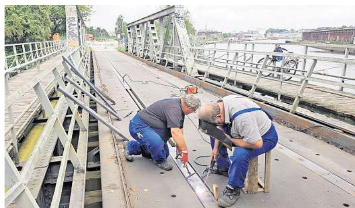
Bereits im Januar und Februar musste die Eutiner Eisenbahnbrücke gesperrt werden. Damals wurden Stahlplatten verbaut, jetzt wird die Brücke umfassender saniert. Foto: Holger Kröger
