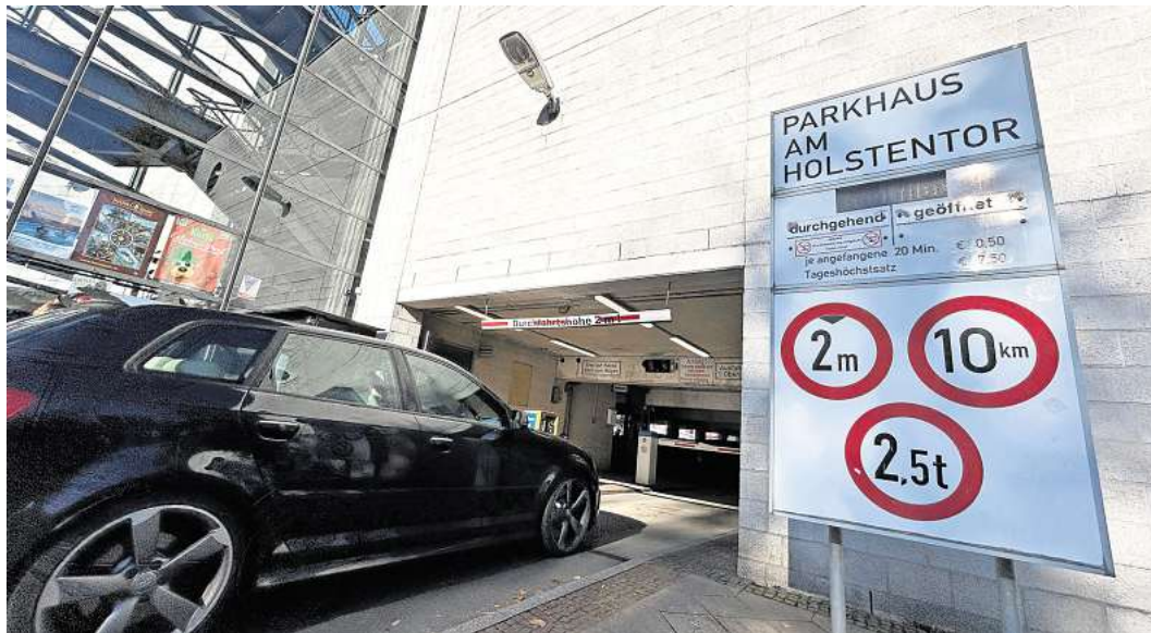
Das Parkhaus am Holstentor mit 510 Stellplätzen wurde 1992 gebaut und zwischendurch immer wieder ertüchtigt. Ende dieses Jahres aber wird es bis auf Weiteres dicht gemacht. Foto: Jana Kubasch
