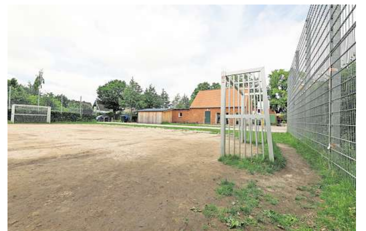
Schon 2017 forderte der Schulverein die Sanierung des Bolzplatzes Groß Steinrade. Acht Jahre später ist es so weit. Foto: Lutz Roeßler
