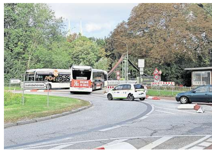
➔ Die Lübecker Mühlentorbrücke ist bis Dezember noch in beide Richtungen befahrbar. Mit dem neuen Fahrplan wird der Busverkehr umgeleitet. Foto: Helge von Schwartz
