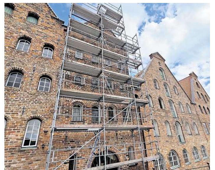
Die Salzspeicher wurden zwischen 1579 und 1745 errichtet. Tritt die Trave über die Ufer, stehen die Keller unter Wasser. Foto: Kröger
