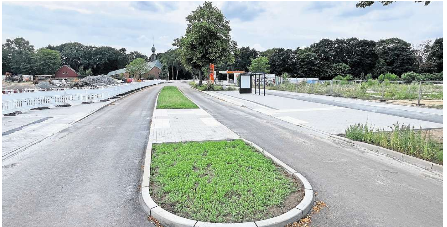
Die Straße ist neu asphaltiert, es gibt Verkehrsinseln, und auch Fuß- und Radweg sind bereits fertig.
