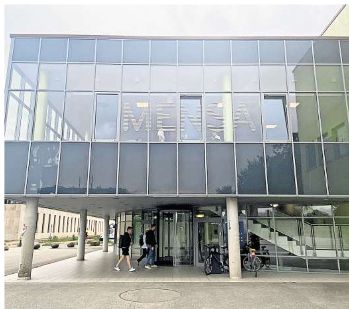
Die Hochschul-Mensa am Mönkhofer Weg wird technisch auf den neuesten Stand gebracht. Foto: Michael Hollinde
