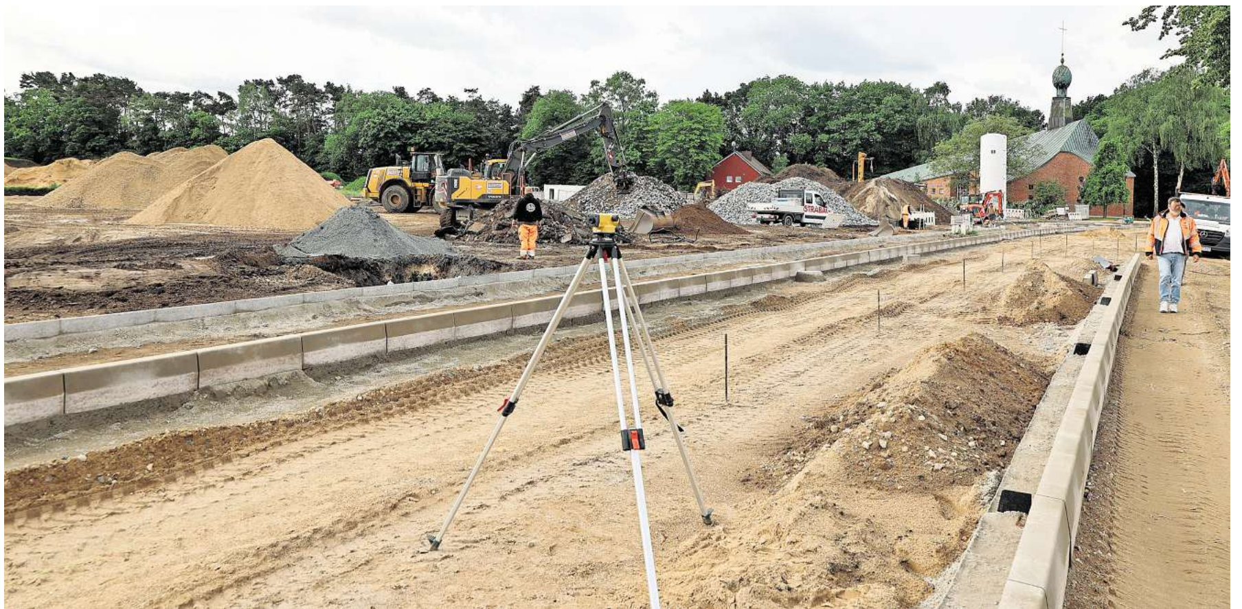
Die Bauarbeiten auf dem Lauerhofer Feld sind seit Monaten im Gang. In St. Gertrud soll ein ganzes Wohngebiet entstehen.
