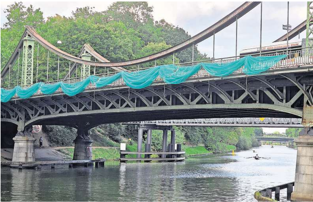
Weil Teile abzaplaten drohen, ist die Mühlentorbrücke derzeit mit Fangnetzen versehen. Demnächst wird die Brücke halbseitig gesperrt. Foto: Holger Kröger
