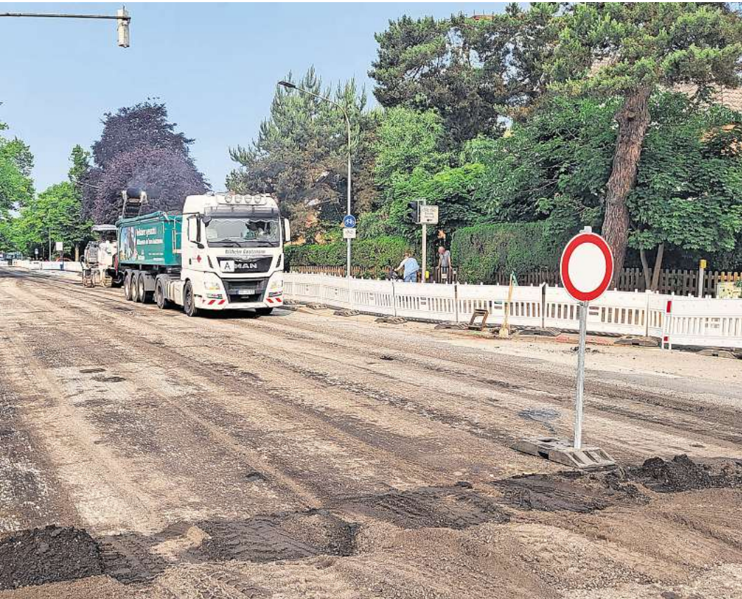
An der Moislinger Allee muss die Stadt sämtliche Fahrbahnschichten erneuern. Entsprechend lange dauern die Arbeiten. Foto: Holger Kröger
