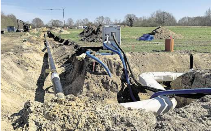
Die neue Fernwärmeleitung im Solarthermiepark wird bereits verlegt, nun folgen die Pfähle für die Kollektoren. Foto: Stadtwerke Lübeck
