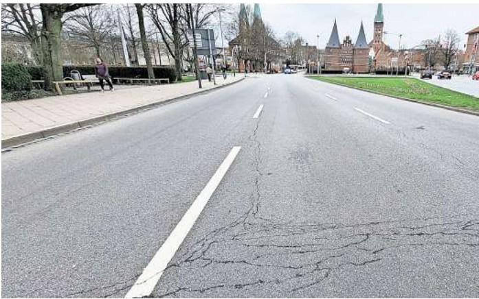
Am Holstentorplatz sind die Risse im Asphalt bereits wieder deutlich zu erkennen.
