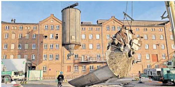
4,5 Tonnen schwer und rund 50 Jahre alt: Die Silos, in denen auf dem Firmengelände von Brüggens Pellets gelagert wurden, sind zerlegt und werden verschrottet. Foto: Holger Kröger
