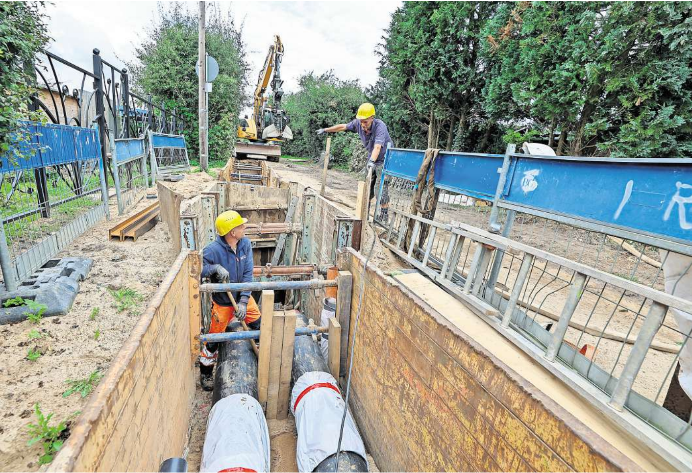
Fernwärme-Ausbau: Mitarbeiter der Firma Bergemann-Gräber verlegen in der Nähe der Schönböckener Straße eine Leitung, die neue Mietwohnungen der Grundstücksgesellschaft „Trave“ anschließen wird. Foto: Lutz Roeßler
