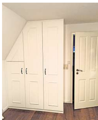
Ein kleiner Schrank wurde genau in die Dachschräge eingepasst und an den Stil der Zimmertüren angepasst. Foto: Die Holzwürmer
