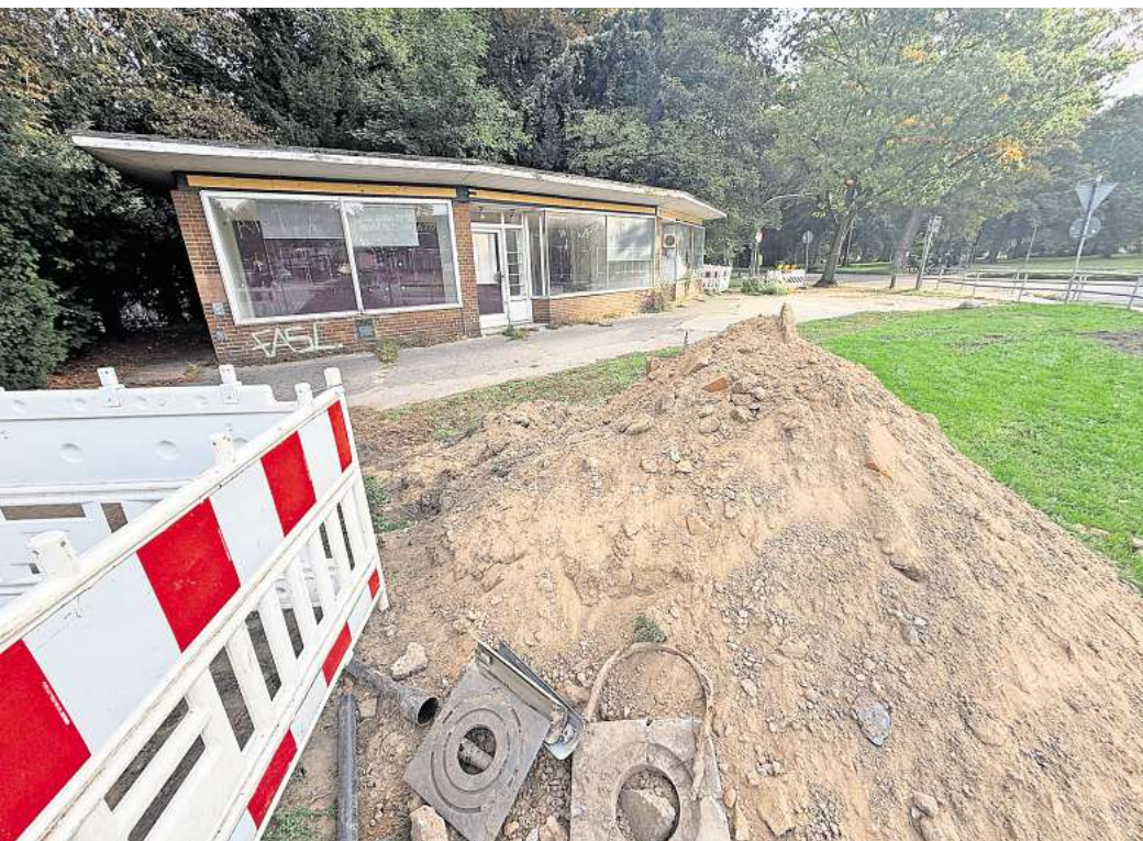
Die Hansestadt Lübeck will den Pavillon am Mühlentortplatz abreißen, um Platz für die Sanierung der Mühlentorbrücke zu schaffen.
