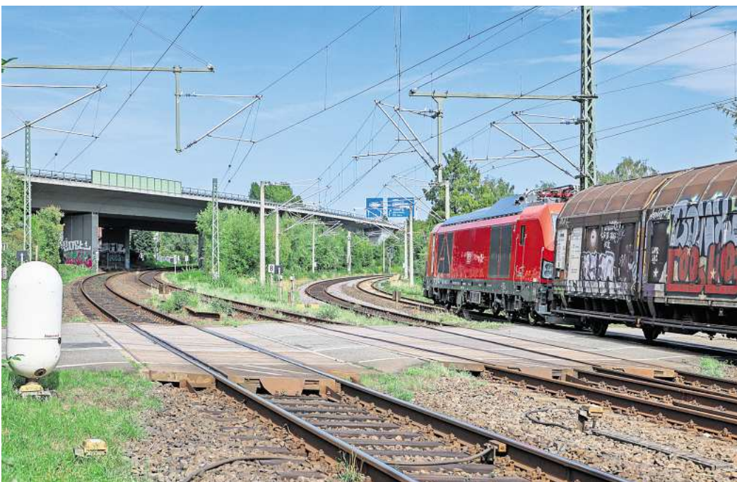
Der Abzweig Waldhalle: Lübeck befürchtet, dass der Streckenabschnitt den künftigen Zugverkehr nicht bewältigen kann. Foto: Lutz Roeßler
