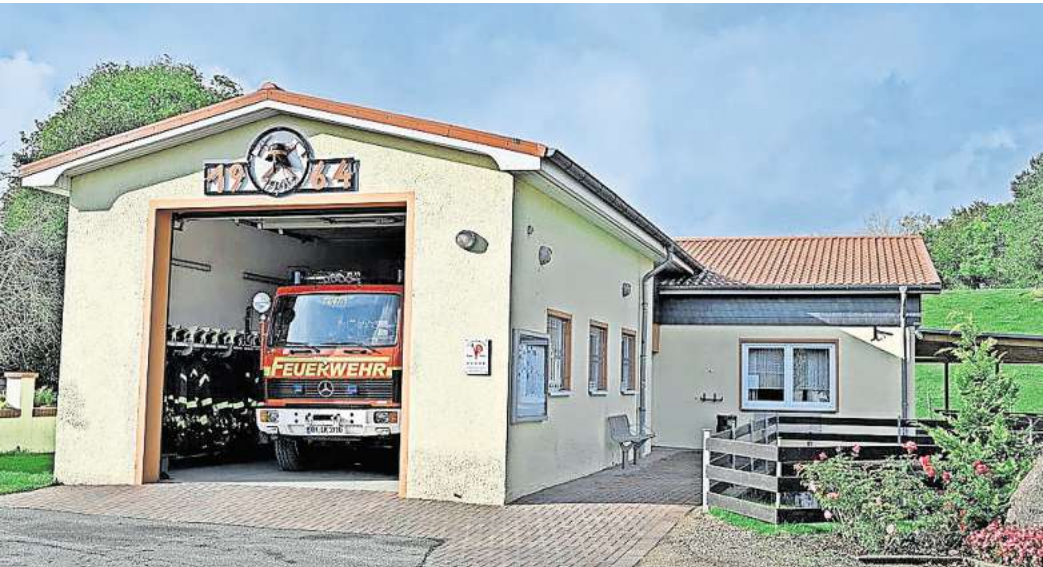
Das Feuerwehrhaus in Liensfeld sollte eigentlich schon durch einen Neubau an anderer Stelle ersetzt worden sein.
