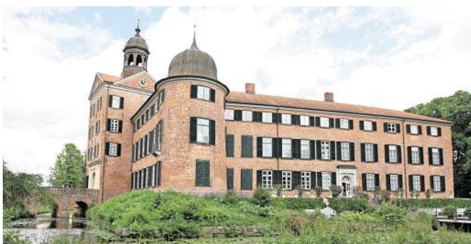
Überall in der Region sind von der Firma Strauch gedeckte Dächer zu sehen wie auch das Dach des Eutiner Schlosses. Foto: jhp
