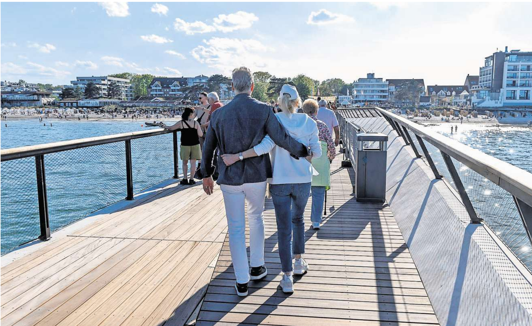
Für die Besucher der Scharbeutzer Seebrücke ist die Beschädigung am Beton, die bei den Arbeiten entdeckt wurde, nicht zu sehen.
