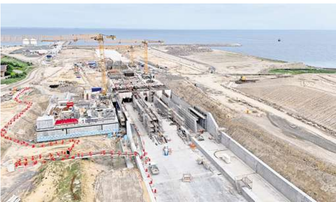
90 Prozent des Tunnelportals im Rohbau sind auf Fehmarn fertiggestellt.
