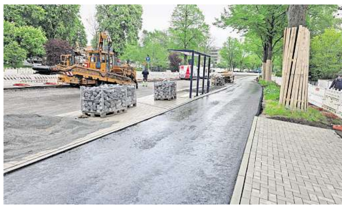
Nahe der Stresemannstraße sind die Arbeiten für den Radschnellweg schon weit fortgeschritten. Foto: Holger Kröger
