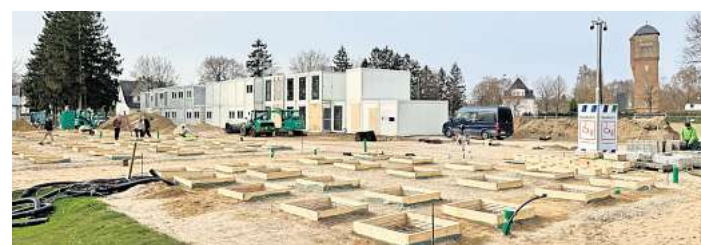
Die Holzverschaltungen für die Betonfundamente zeigen die Standorte, an denen die Wohncontainer aufgestellt werden. Foto: Dirk Schneider
