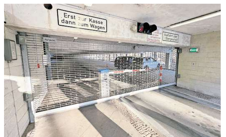
Das Parkhaus Holstentor Lübeck ist bereits geschlossen.
