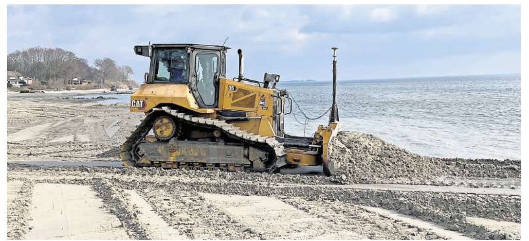
In Sierksdorf wird Sand aufgespült und verteilt. Die Arbeiten laufen rund um die Uhr.
