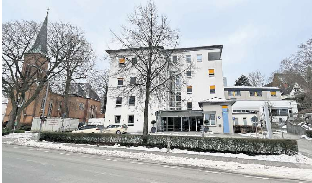
Bis auf eine Station ist das Altgebäude mit angefügten Flügeln an der Plöner Straße leer, erste Sanierungs- und Modernisierungsarbeiten sind bereits angelaufen. Fotos: Ulrike Benthien
