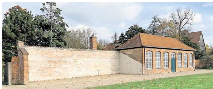
Im kommenden Jahr wird eine Bildungsküche im Neuholländerhaus eingebaut. Draußen sind Sitzgelegenheiten vorgesehen. Foto: BEN
