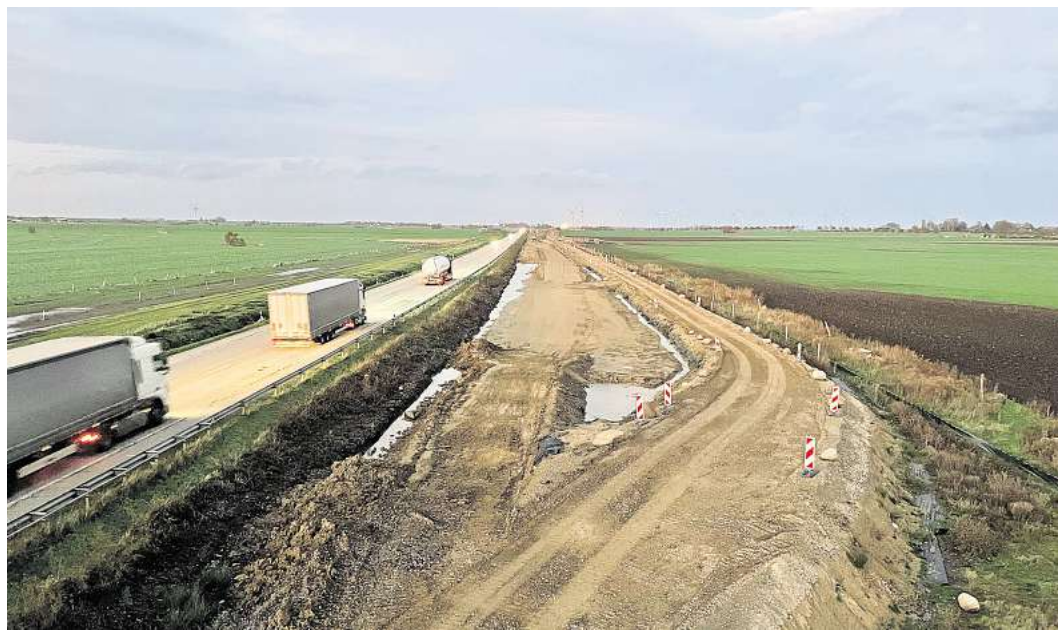
Auf der alten Bundesstraße zwischen Burg und Puttgarden wird direkt neben der Fahrbahn schon kräftig für die Hinterlandanbindung des Beltunnels gebuddelt. Foto: Sven Wehde
