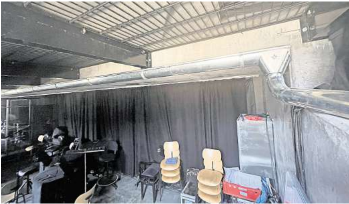
Um Wasser vom Orchestergraben fernzuhalten und abzuleiten, haben die Festspiele eine Dachrinne montiert. Foto: Ulrike Benthien
