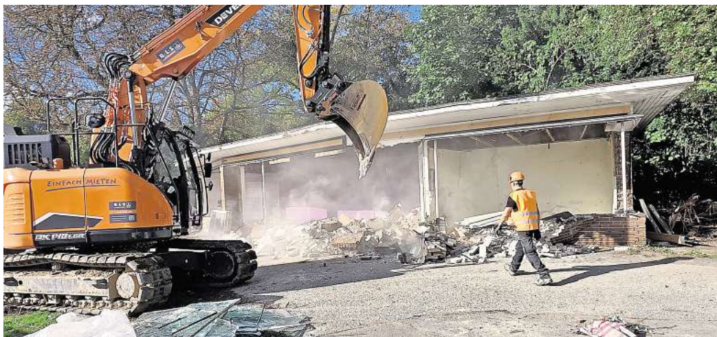
Das Ende des Pavillons: Mit einem Bagger reißen Arbeiter das Gebäude am Lübecker Mühlentorplatz ab. Foto: Holger Kröger
