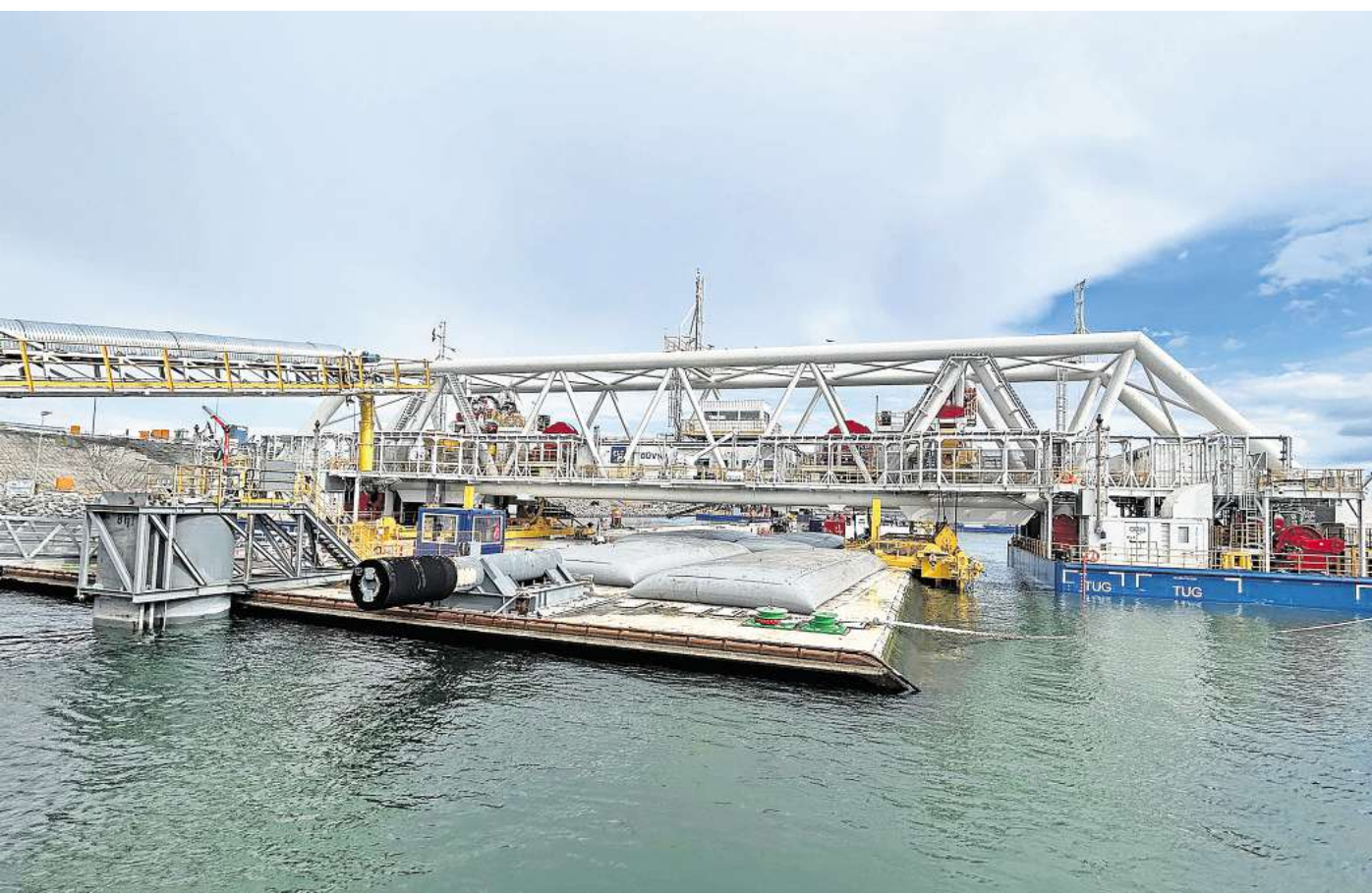
Der Absenkponton „Ivy“ wurde für das Absenken eines Spezialelements erfolgreich getestet und zugelassen. Um das Gewicht des Elements während des Tests zu erhöhen, wurden auf seiner Oberseite große mit Wasser gefüllte Ballastsäcke angebracht. Foto: Sund & Bælt
