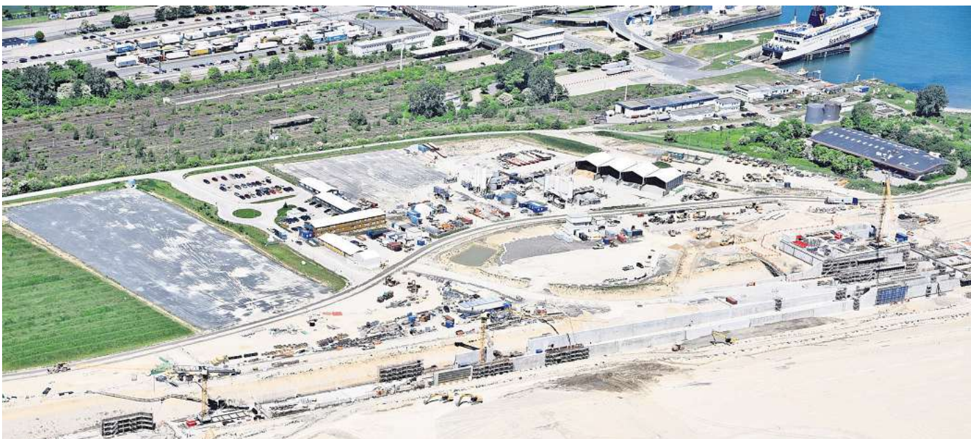
Schwindelerregende Dimensionen: die Baustelle am Tunnelportal in Puttgarden auf Fehmarn.
