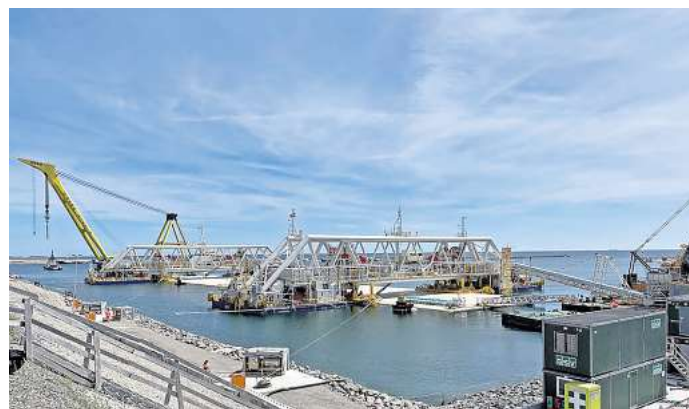
Das zweite Tunnelelement, das vor Dänemark abgesenkt werden soll, wird von den Spezialschiffen „Ivy1“ und „Ivy“ gehalten. Sobald die Wetterbedingungen stimmen, kann es losgehen.
