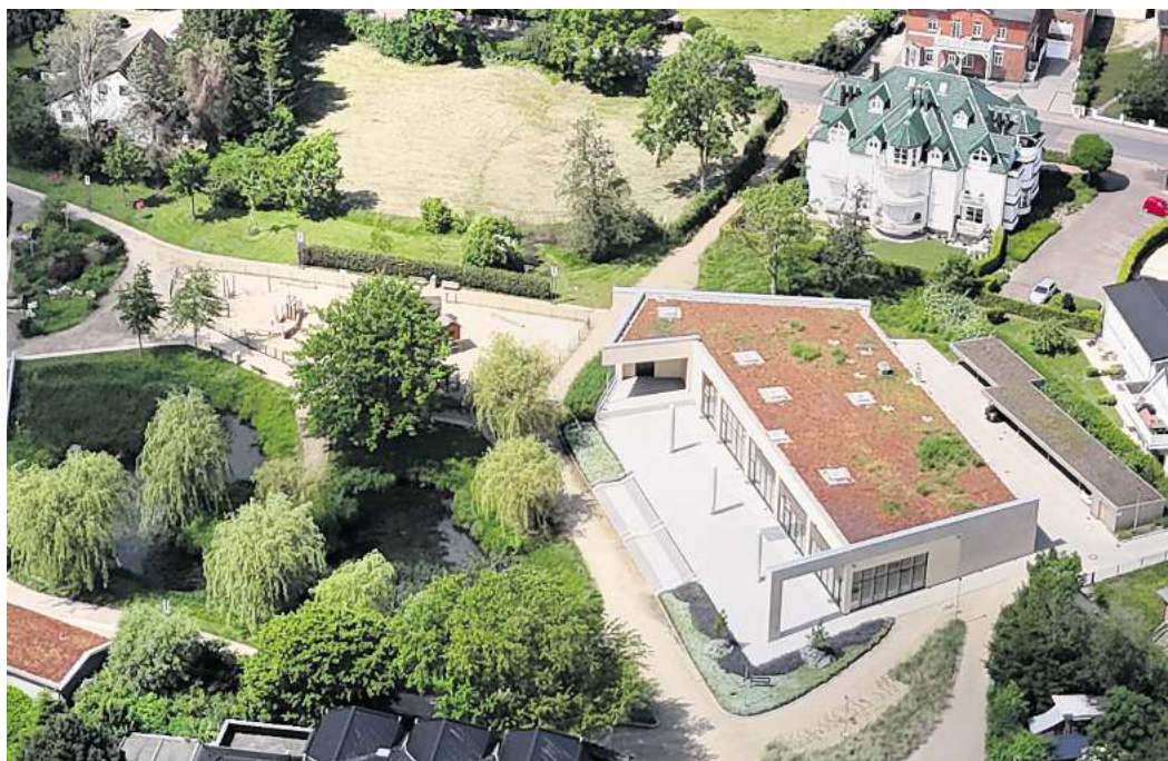
Das Haffhuus im Haffwiesenpark soll bald durch einen neuen Pächter belebt werden. Die Tourismus-Agentur Lübecker Bucht organisiert bereits Veranstaltungen in dem 2022 neu gebauten Gebäude.
