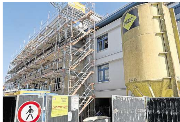
Die Straße vor der Baustelle ist seit Monaten abgesperrt. Kein Wunder: Der Bauplatz ist äußerst begrenzt.
