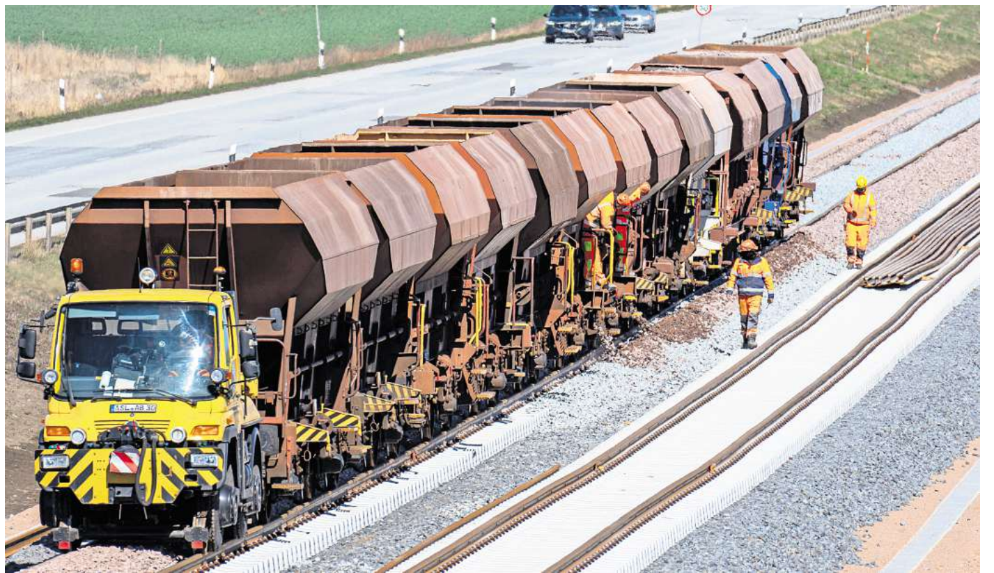
Die Gleise auf Fehmarn werden mit Schotter verfüllt. Die Insel ist bisher der einzige Ort, an dem für die neue Trasse schon gebaut wird. Foto: Deutsche Bahn
