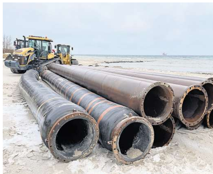
So sieht der Strand von Sierksdorf derzeit aus. Er ist schmal, und es fehlt sichtlich an Sand. Doch es liegen schon dicke Rohre bereit, durch die Sand vom Schiff aus an Land gespült werden soll.
