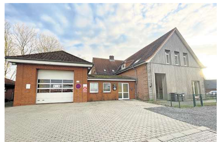
Ein Teil des ehemaligen Kindergartens in Groß Meinsdorf (r.) wird für die Freiwillige Feuerwehr umgebaut. Außerdem sollen in dem Gebäude drei Mietwohnungen entstehen. Foto: Ulrike Benthien
