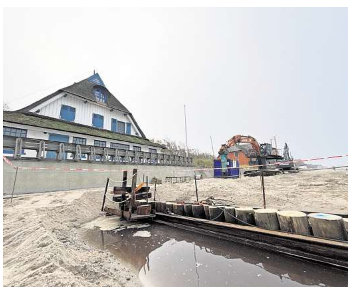
Die Eigentümer der Häuser am Graswarder lassen die Bühnen auf eigene Initiative bauen. Foto: Maïke Wegner
