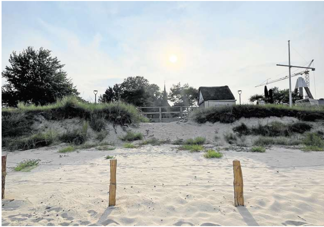
Das Sturmhochwasser im Oktober 2023 setzte der Strandarena, die direkt gegenüber der Strandkirche lag, heftig zu. Ihr ehemaliger Standort ist abgesperrt. Foto: Ulrike Benthien
