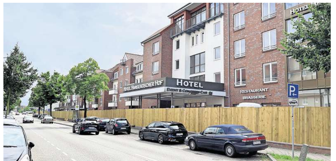
Ein hoher Bauzaun umgibt seit Kurzem das gesamte Gelände des Hanseatischen Hofes in Lübeck. Erste Arbeiten für die geplanten Umbauten sind angelaufen. Foto: Oliver Pries
